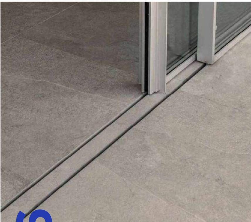
Déclinée également dans la série INV36, votre menuiserie minimaliste BAILUX se fait encore plus discrète grâce au recouvrement des rails au sol par le matériau de finition. Seule une fente visible au sol marque discrètement la séparation entre intérieur et extérieur.
